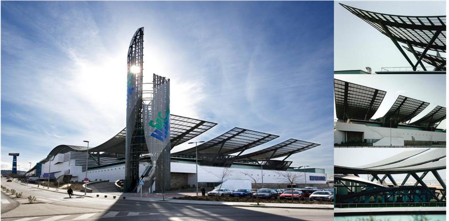
La existencia de una forma en onda longitudinal, sugiere la existencia de dos elementos: un arco coincidente con la zona con curvatura positiva (hacia arriba) y un elemento colgado (tirante) en la zona con curvatura negativa (hacia abajo).
